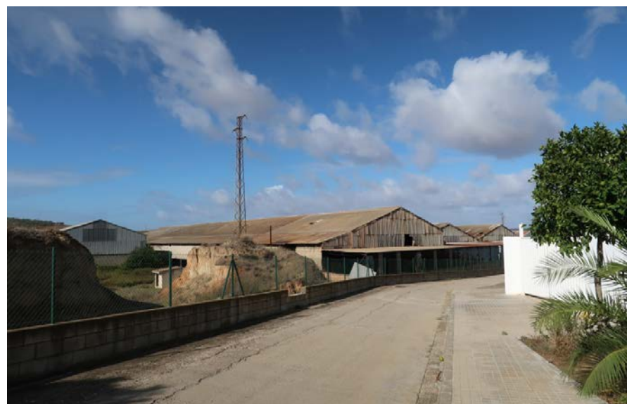
Antigua fábrica de ladrillo abandonada en la actualidad, propuesta como ATU residencial.
