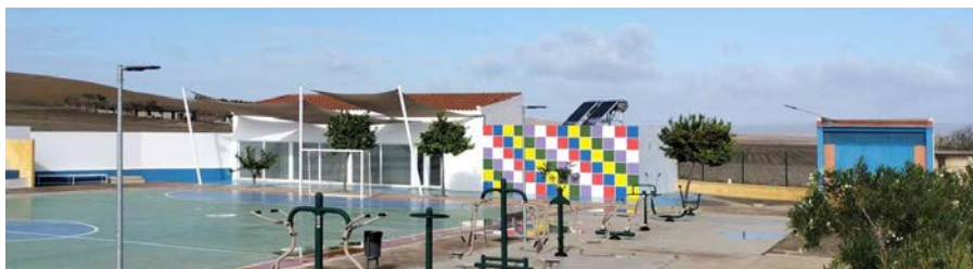
Edificios con placas fotovoltaicas en el núcleo principal
